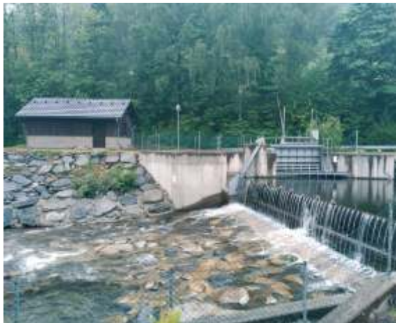
Obr. 8 Z vodní nádrže nad splavem regulovaně odtéká voda náhonem k turbíně (stavidlo v horní části obrázku) a do rybochodu (v dolní části obrázku je vidět horní plocha stěny rybochodu).
