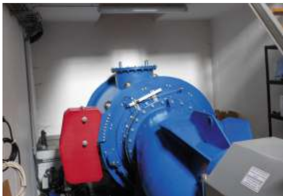
Obr. 10 Malá Kaplanova turbína je uváděna do chodu jen při dostatečném průtoku vody v řece. Natur Energo s.r.o. důsledně tyto regulační podmínky dodržuje. Všichni provozovatelé obdobných i větších zařízení tyto regulační podmínky občas nerespektují, a tím mohou poškodit životní prostředí pro vodní živočichy.
