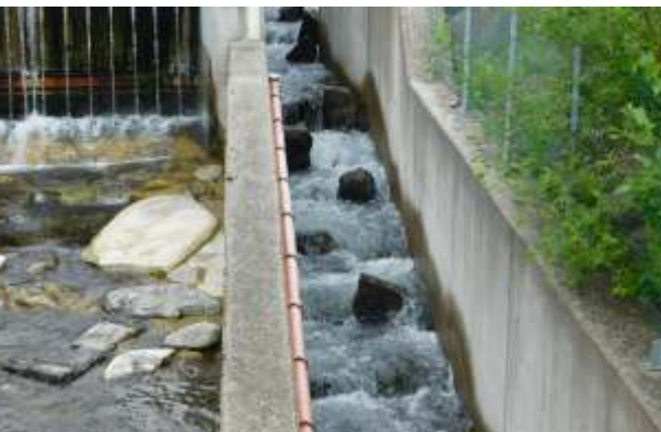
Obr. 9 Přehrazením řeky vznikla vodní nádrž pro náhon k turbíně. Aby se mohly ryby volně pohybovat v řece nad i pod splavem, je vybudován rybochod s mírným sklonem a tůňkami kolem kamenů na jeho dně.
