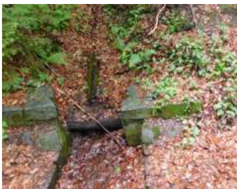
Obr. 5 Jednoduchý žlábek kolem lesní cesty zachycuje vodu stékající ze svahu nad cestou, vytváří malé tůňky a v době sucha postupně uvolňuje vodu do lesního porostu.
