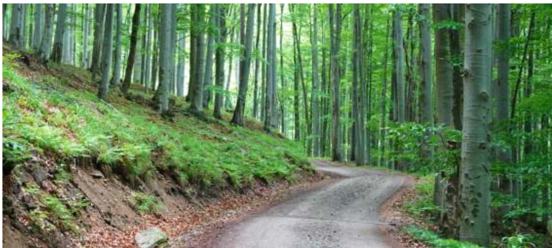
Obr. 4 Tato lesní cesta vznikla a je udržována výhradně zhuštěním rozdrčeného místního materiálu tvořeným kamením, drobnou suti a úlomky rostlinného materiálu. Mohou po ní jezdit i těžké stroje, rychle vsakuje dešťovou vodu a osychá po dešti, je naprosto ekologickým prvkem.
