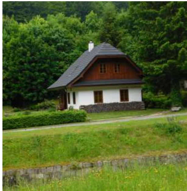
Obr. 3 Novostavba v původním slohu umístěná v nivě nad korytem Hučivé Desné. Na přední části fotografie je vidět kamenná zídka zpevňující břeh strouhy kolem silnice a zachytávající vodu ze svahu.
