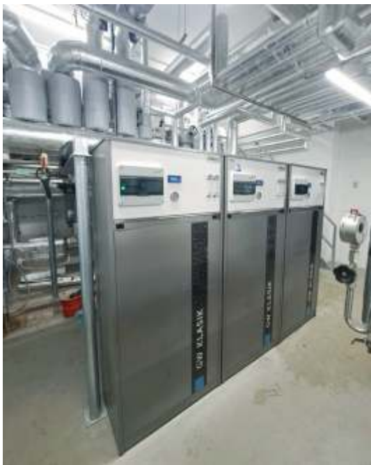
Reverzní osmóza v sériovém zapojení o výkonu přes 3 000 l/hod pro výrobu páry. Foto: Šárka Burýšková
