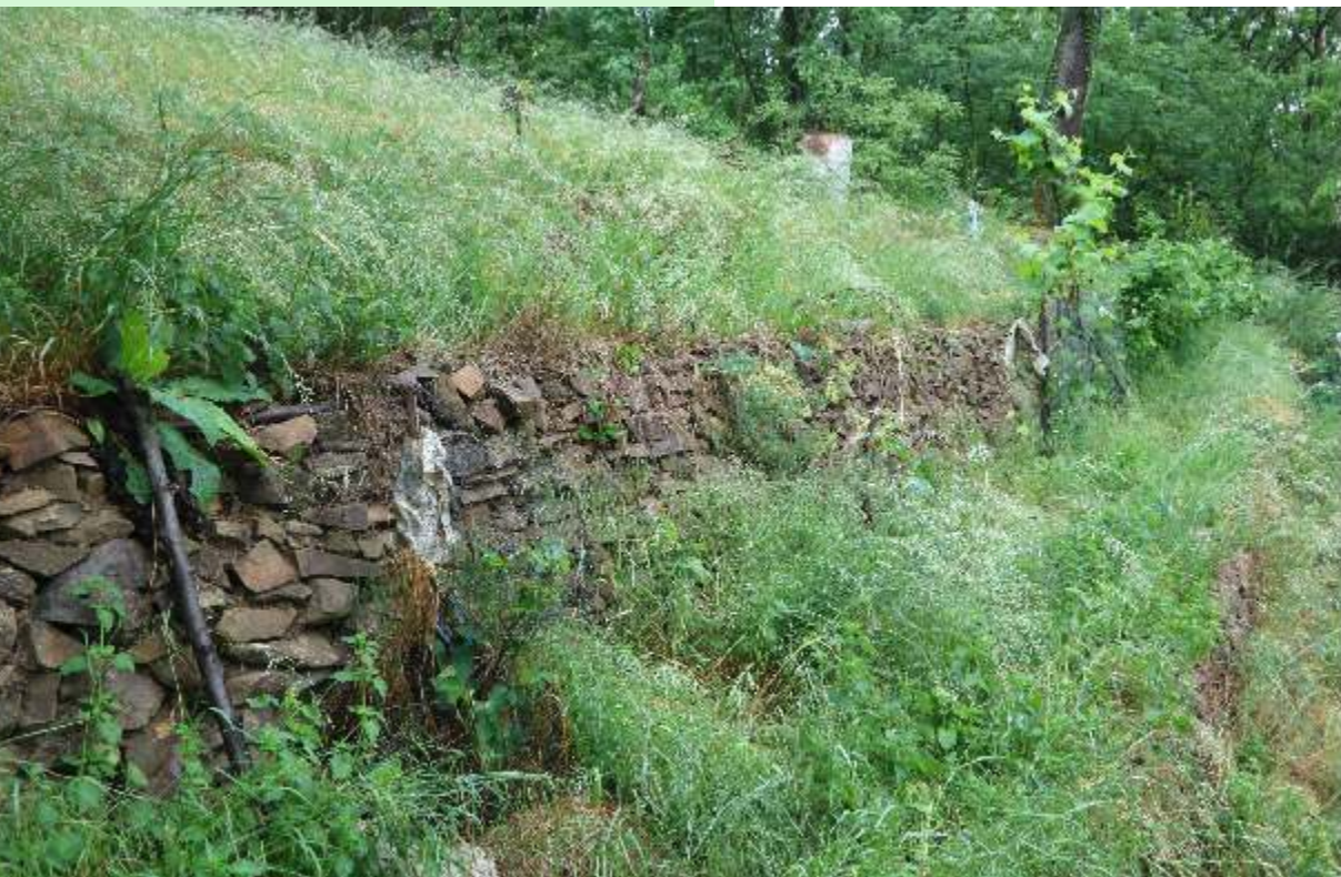
Obr. 2 – Před 2 roky obnovené dva stupně suchých zídek s novou výsadbou čekají na šetrnou seč a ošetření po odeznění letošní první květnové vlny sucha a veder. I pokrytí usychající trávou a plevelem je v období sucha lepší než obnažená půda
